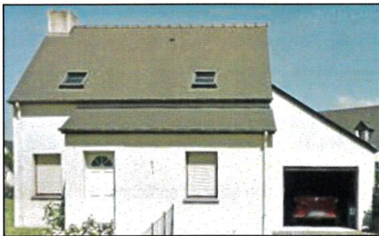
Garage dans un volume secondaire en appentis. Volume secondaire en façade avec une pente différente du volume principal.
