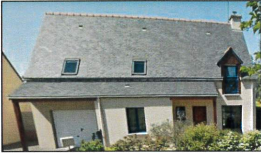
Garage dans le volume principal et volume en avancée de la façade, la pente de toitures est différente de la pente du volume principal.
