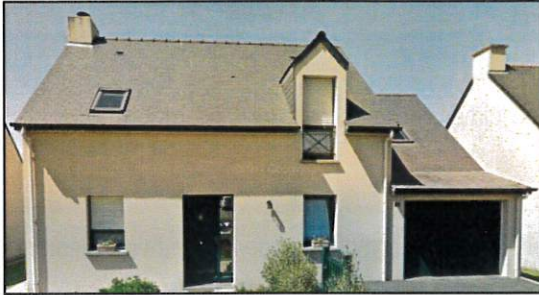
Garage dans un volume secondaire à deux pentes différentes.
